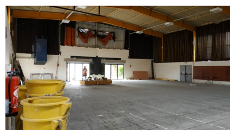
Rénovation du gymnase
